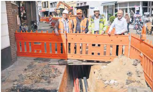
Sind mit dem Ablauf der Tiefbauarbeiten auf der Judenstraße bisher sehr zufrieden (von links): Hubertus Kinkel von den Stadtwerken, Schachtmeister Jörg Wagner von der Firma Hamelmann, Michael Schwartz vom betreuenden Ingenieurbüro BFT aus Aachen und Geschäftsmann Stephan Bunsse von der Händlergemeinschaft. RF PHOTO: WOLFGANG KASER
