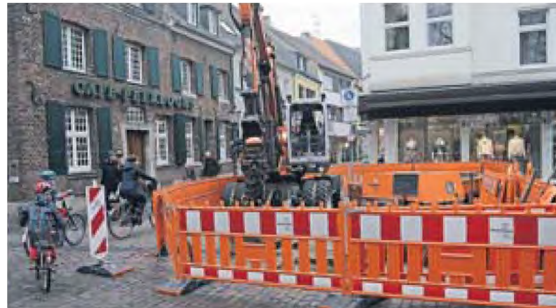
Am Kempener Buttermarkt – an der Einmündung Judenstraße – haben gestern die Tiefbauarbeiten begonnen. Sie werden 14 Monate dauern.
