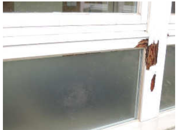
Abbildung 4: Detailansicht Holzrahmenfenster
