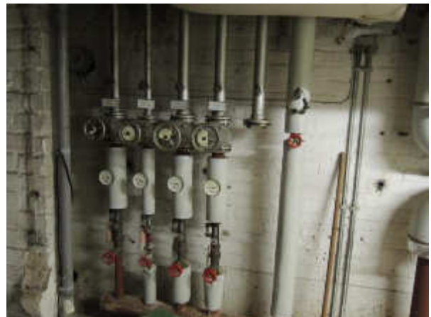
Abbildung 4: Heizungsverteilung
