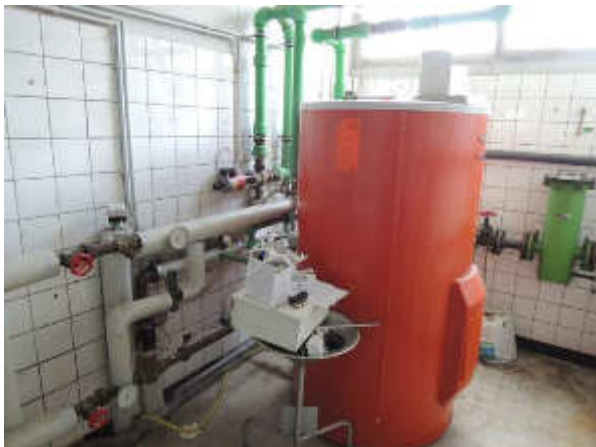
Abbildung 3: TWW-Speicher alte Turnhalle
