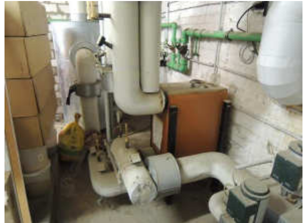
Abbildung 2: Platten-Wärmetauscher
