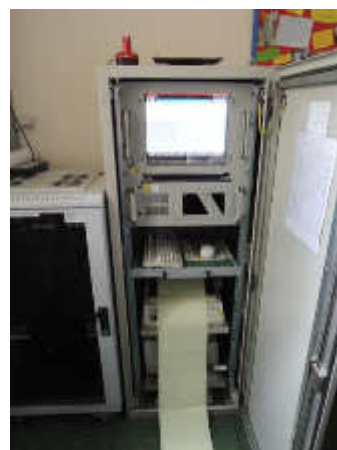
Abbildung 6: Alte Gebäudeleittechnik Fabrikat Bordsen
