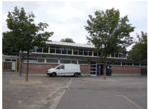
Abbildung 2: Gebäudehülle neue Turnhalle
