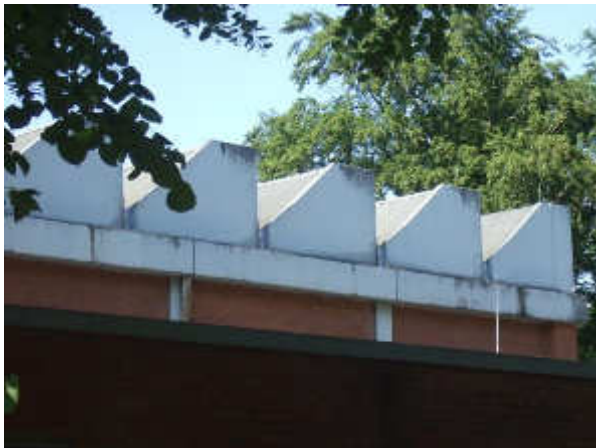
Abbildung 1: Seitenansicht Sheddach
