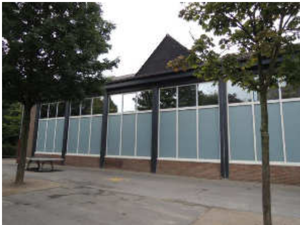
Abbildung 1: Gebäudehülle alte Turnhalle
