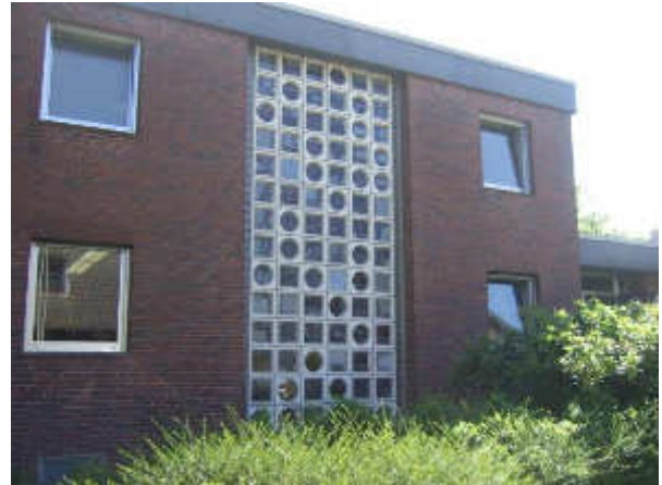
Abbildung 2: Bleiverglasung im Treppenhaus
