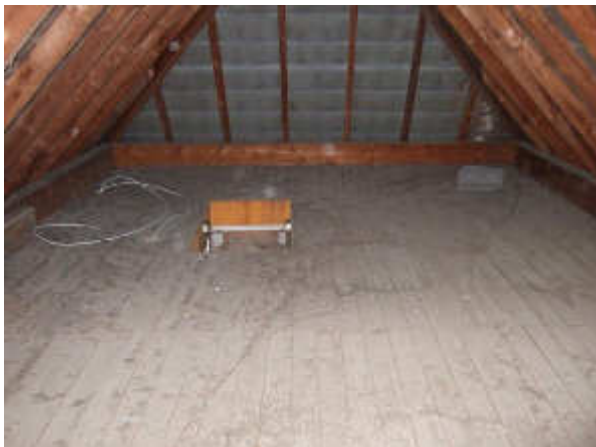
Abbildung 3: Ungedämmte oberste Geschossdecke
