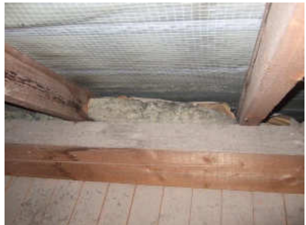
Abbildung 4: Dämmung der Dachschrägen
